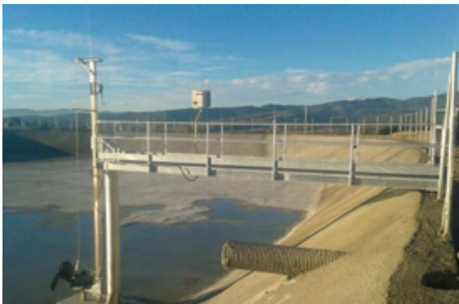
**SOPORTE PARA BALSAS TALUD CON APOYO INTERIOR**
